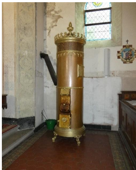
Piec żeliwny w kościele filialnym pw. Św. Jana Chrzciciela w Chmielnie wyprodukowany w końcu XIX w. w założonej w 1887 roku przez inż. H. Kori w Berlinie firmie, która zasłynęła z produkcji pieców do spalania odpadów i kalorycznych podgrzewaczy powietrza, używanych zwłaszcza w budynkach kościelnych.
