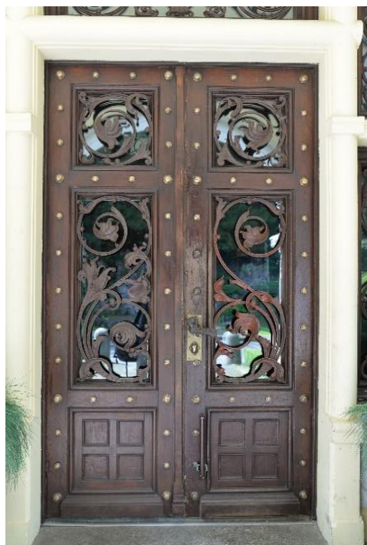
Neobarokowa krata i klamki na drzwiach wejściowych do Bursztynowego Pałacu – 1901 r.
