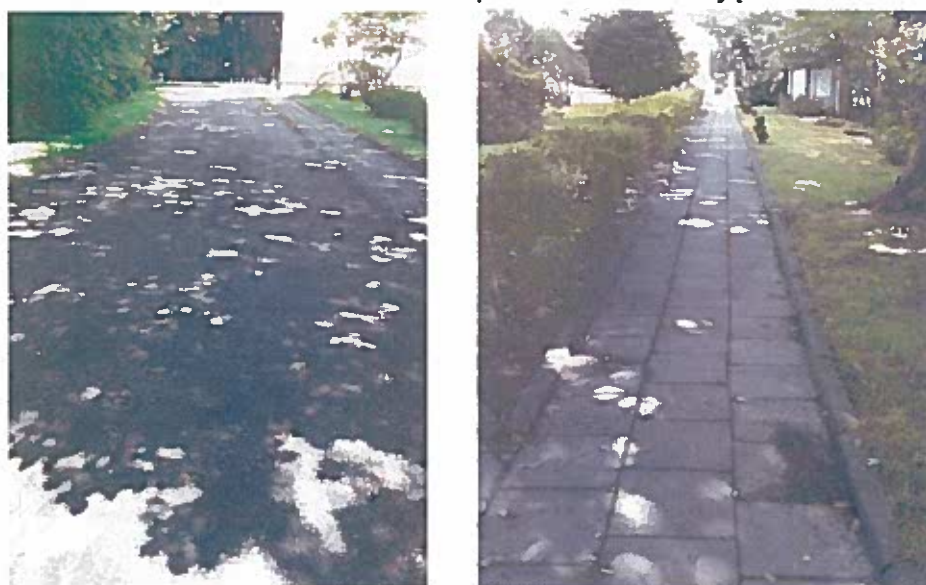
Stan nawierzchni przed modernizacją
