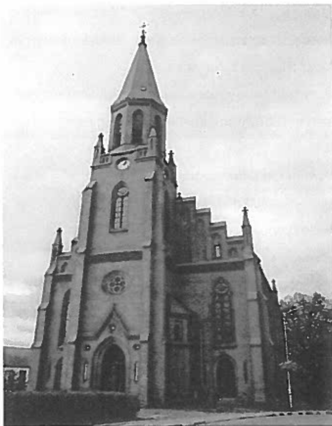
Kościół Rzymsko-Katolicki p.w. Wniebowzięcia NMP w Bobolicach
