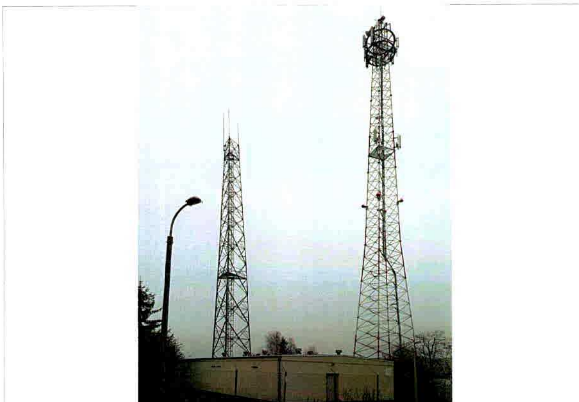
Fot. 1. Widok wieży EOP191 - Polanów - Bazowa (po lewej stronie)
