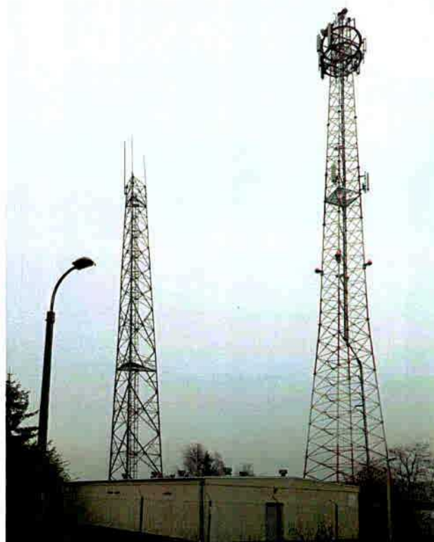
Fot. 1. Widok wieży EOP191 - Polanów - Bazowa (po lewej stronie)
