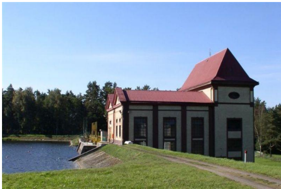
Młyn i elektrownia wodna w Niedalinie.
