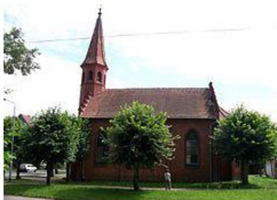
Kościół prawosławny p.w. Wszystkich Świętych w Bobolicach wybudowany w końcu XIX wieku. Styl neogotycki - materiałem budowlanym była cegła i gładki granit.
