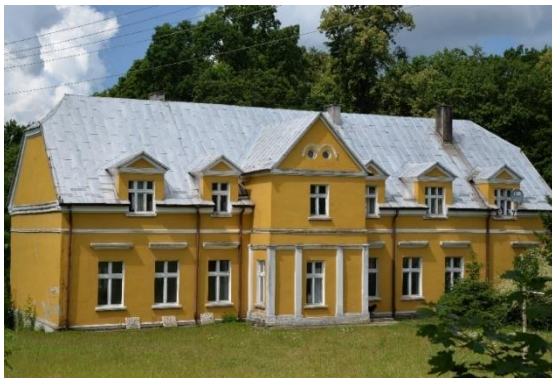
Dwór we wsi Bożniewice wybudowany w połowie XIX w. Do wzniesienia dworu wykorzystano fundamenty wcześniejszego budynku z zachowanymi piwnicami.
